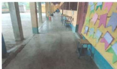
FOTO 5: REPARACIÓN O SUSTITUCIÓN DE PISO
