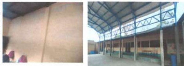
FOTO 1: PINTURA EN MUROS INTERIOR Y EXTERIOR
