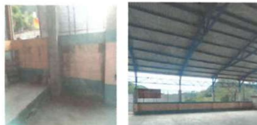
FOTO 2: PINTURA EN MUROS INTERIOR Y EXTERIOR
